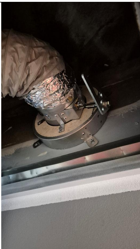
Foto 15. Tubadesse viivate ventilatsioonitorude EIS klassi tuletõkkeklapid.
