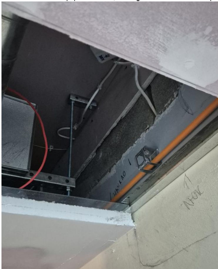
Foto 1. Väljaehitatud tulekindel vahelagi koridori osas EI60 tuletõkkeksektsiooni moodustamiseks.
