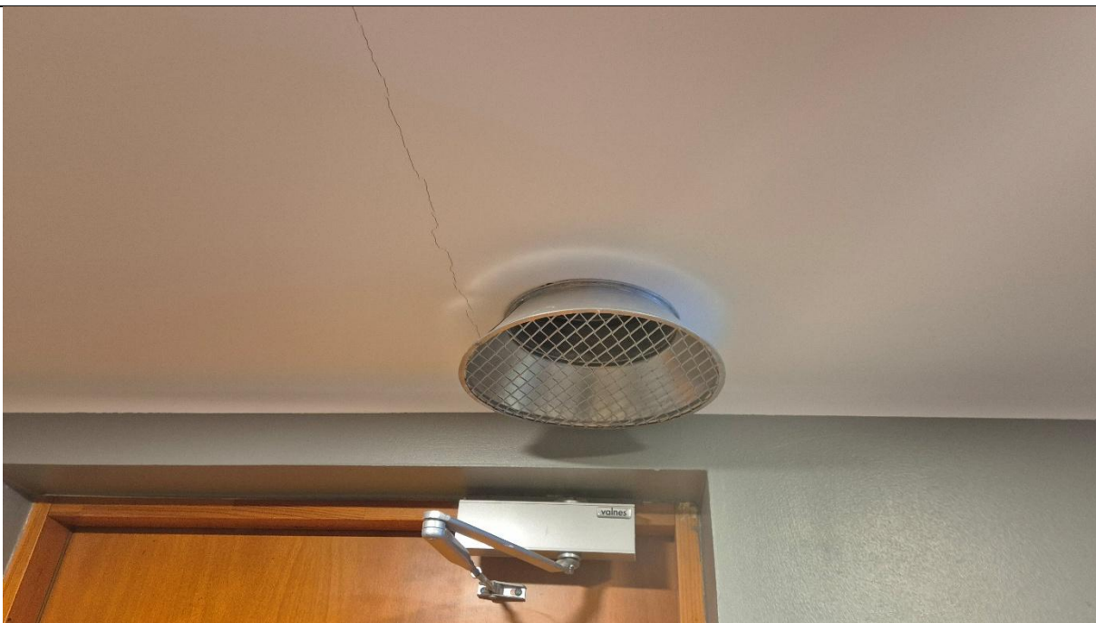
Foto 21. B-korpuse 2-korruse mehaanilise suitsueemalduse väljatõmme.
