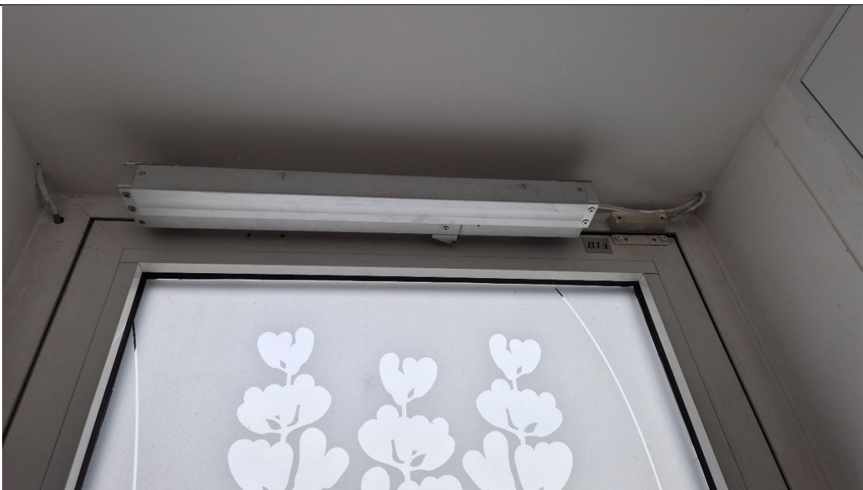
Foto 23. Koridoride mehaanilise suitsueemaldussüsteemi kompensatsiooniõhu ukse ajam. Koridori tsooni käivitamisel avatakse uks ajami abil õhu kompensatsiooniks.
