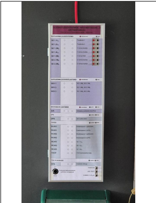
Foto 9.Vastuvõtulaua juures paiknev tuletõrje infotabloo millelt on võimalik käivitada suitsueemaldustsoone ning kus kuvatakse süsteemi korrasoleku info.
