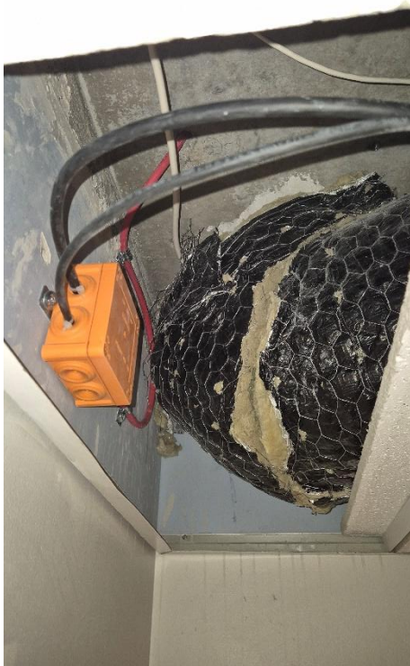
Foto 11. A korpuse 1 korruse mehaanilise suitsueemalduse isoleeritud väljatõmbetoru ja suitsuklapi ühenduste tulekindel harukarp.
