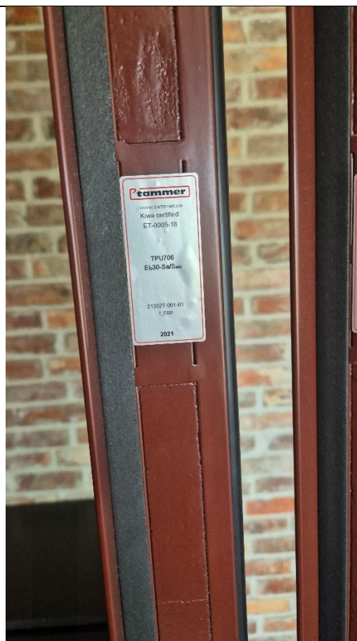
Foto 6. A-korpuse 1 korruse randvere tee poolne evakuatsioonipääsu ja restorani osa eraldav tuletõkkeuks tulepüsivusega EI30 S200
